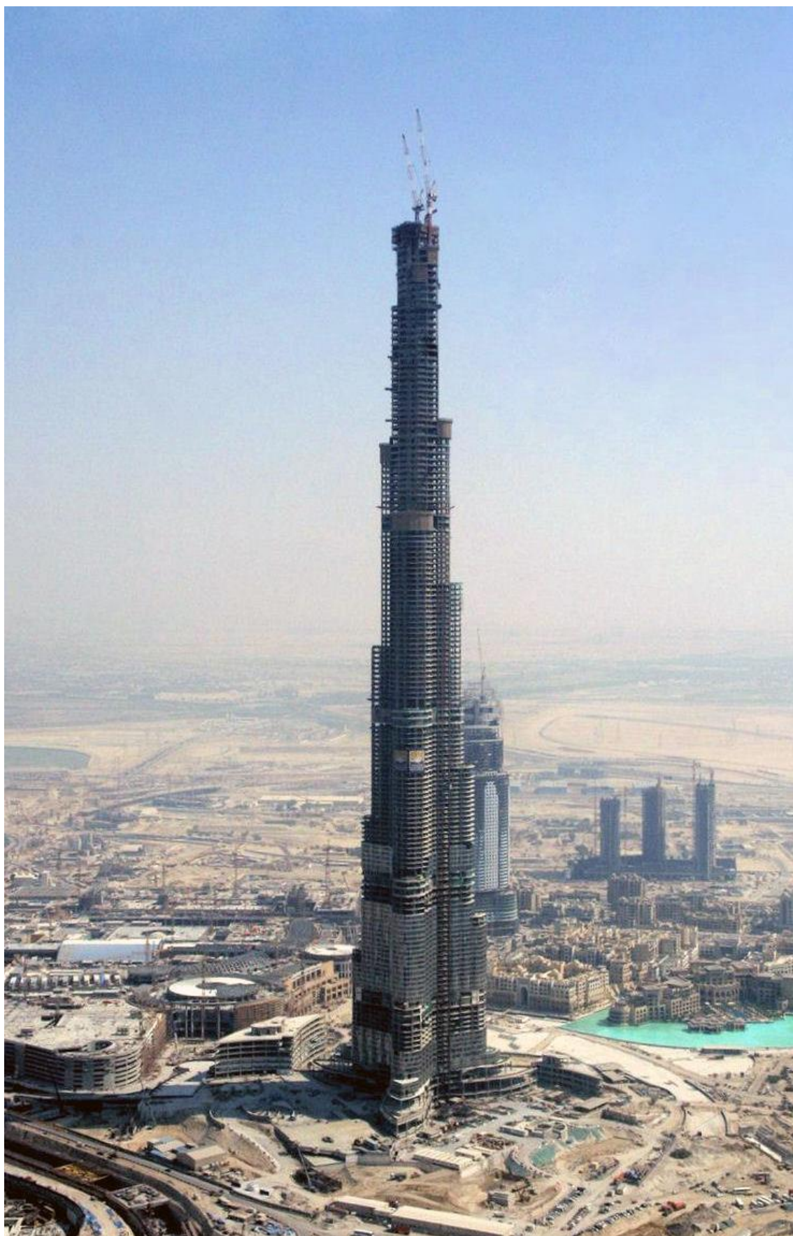
Figura 9 - Burj Dubai em construção (outubro de 2007)
