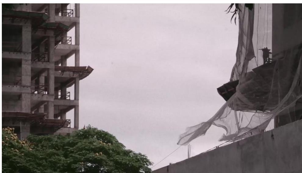
Figuras 6, 7 e 8 - Prédios em construção em Nova Dubai
